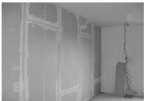
Внутренняя отделка – 2 слоя гипсокартона
