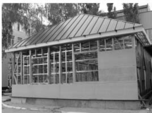
Обшивка утепителем URSA П30
